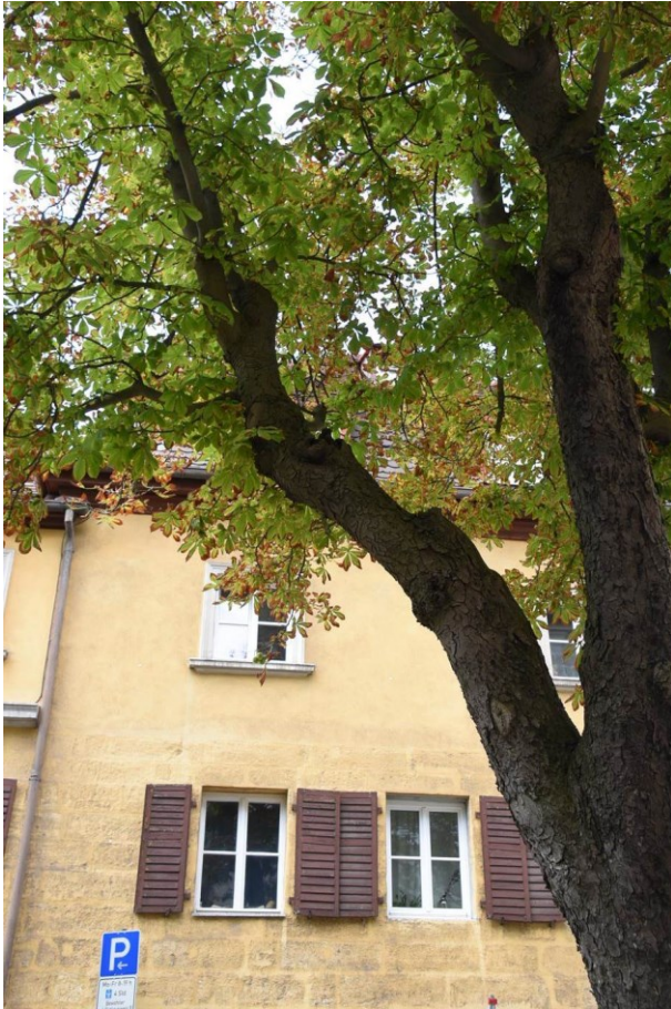
Bild 47: Der südliche Stämmling ragt über die Straße
