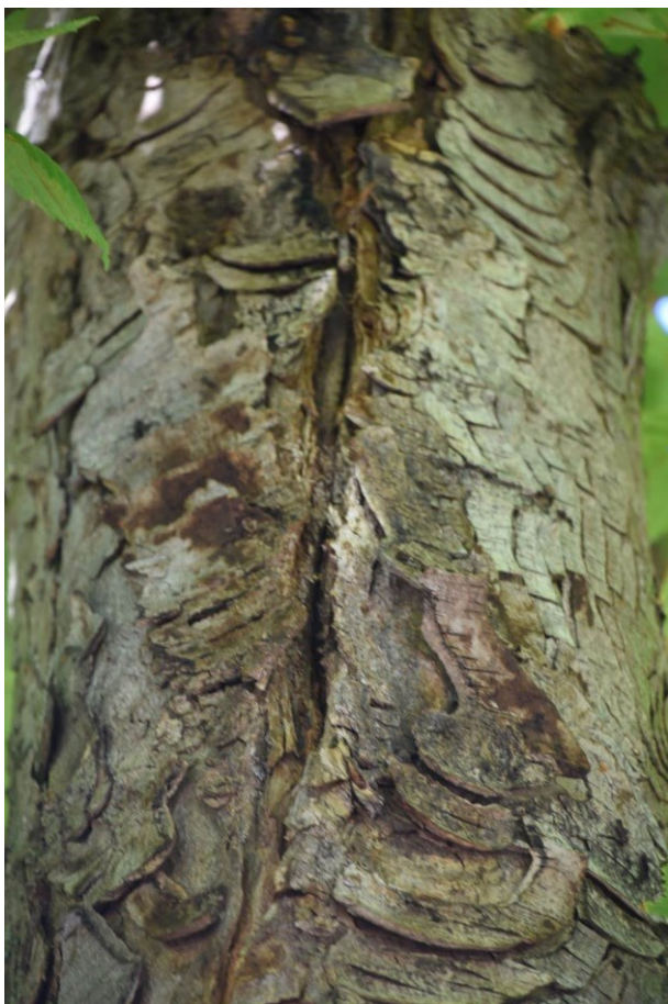
Bild 17: Der Riss im östlichen Stämmling ist tiefgehend
