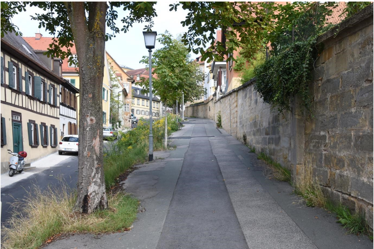
Bild 8: Wegen der kürzlich durchgeführten Leitungsgrabungen sind erhebliche Wurzelschäden von 25-35 % entstanden, da die Baugrube nur 1 m am Stamm längs verläuft
