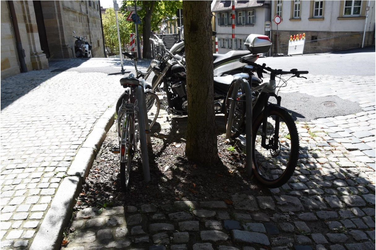
Bild 37: Die Kastanie steht in kleiner Baumscheibe - der restliche Standort ist versiegelt – Pflaster mit dichten, betonierten Fugen; vor Kurzem wurde südwestlich in ca. 3 m Entfernung ein Leistungsgraben gegraben und sicherlich Wurzeln abgegraben, was die Ursache der abgestorbenen Äste in der westlichen Krone sein dürfte
