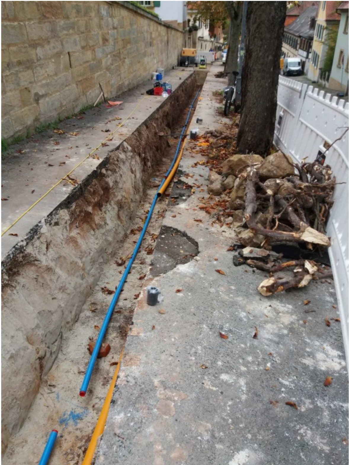
Bild 2: Der Leitungsgraben wurde ca. 1 m von den Kastanienstämmen verlegt, darin wurden alle vorhandenen Wurzeln bis 1 m Tiefe abgebagert – rechts Wurzelstücke von Kastanien. In der nördlichen Baugrubenwand steht teilweise massiver Sandsteinfels des Sandsteinkeupers an.
