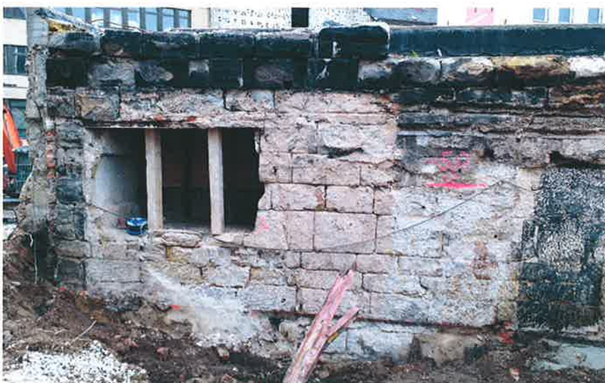
3. Blick n. SW, Feldseite der älteren Stadtmauer
