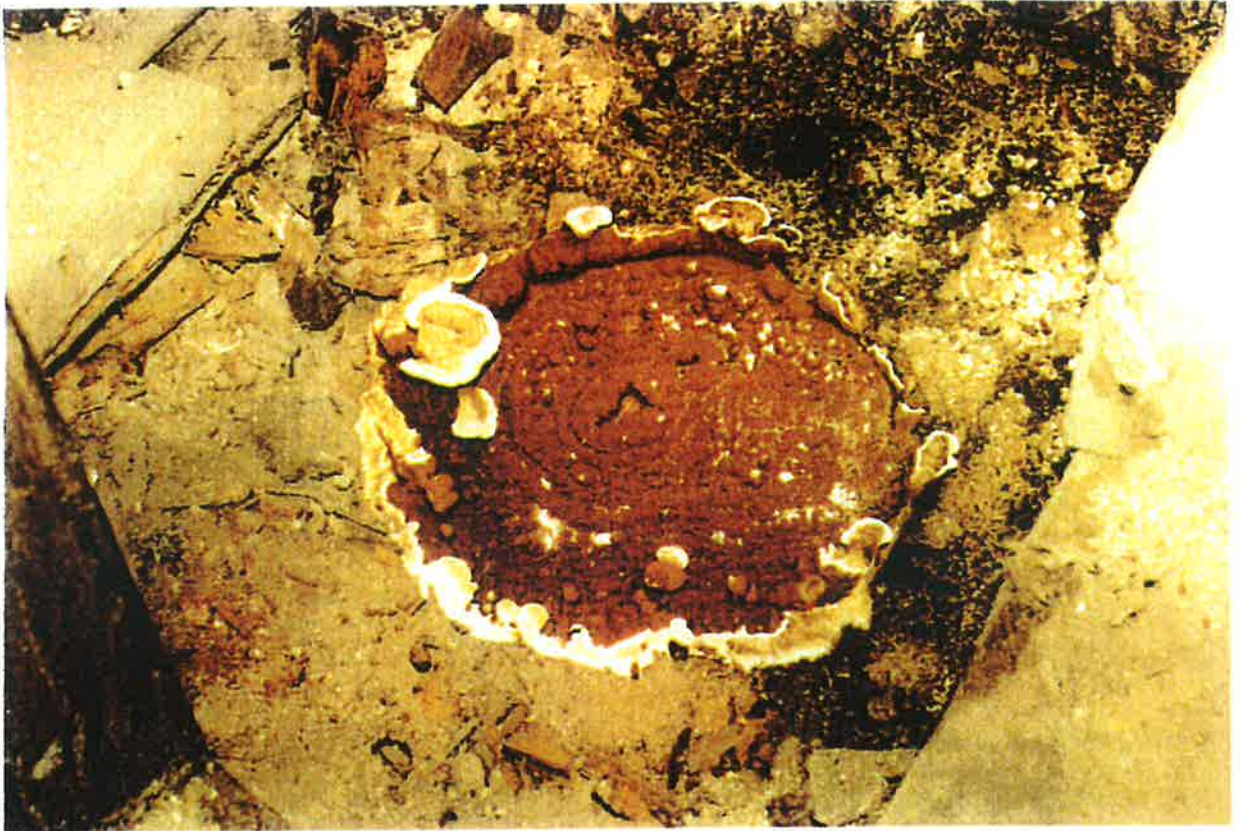
Bild 8.10. Echter Hausschwamm: Fruchtkörper auf der Außenwand einer Kirche auf Natursteinmauerwerk (!); Bildung innerhalb von 3 Wochen.
