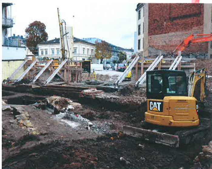
2. Blick n. NO, Stadtseite der abgestützten Reste der jüngeren Stadtmauer
