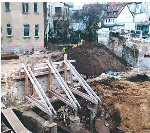
1. Blick n. SO, vorne die abgestützte jüngere Stadtmauer, rechts hinten die ältere
