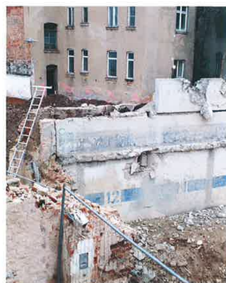
4. Blick n. O., zum Teil abgebrochene Betonscheibe von der Stadtseite der älteren Stadtmauer
