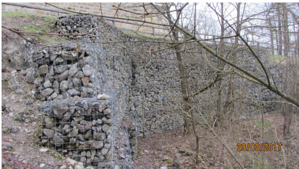
Blick auf die 2001 abgeschlossene Maßnahme
