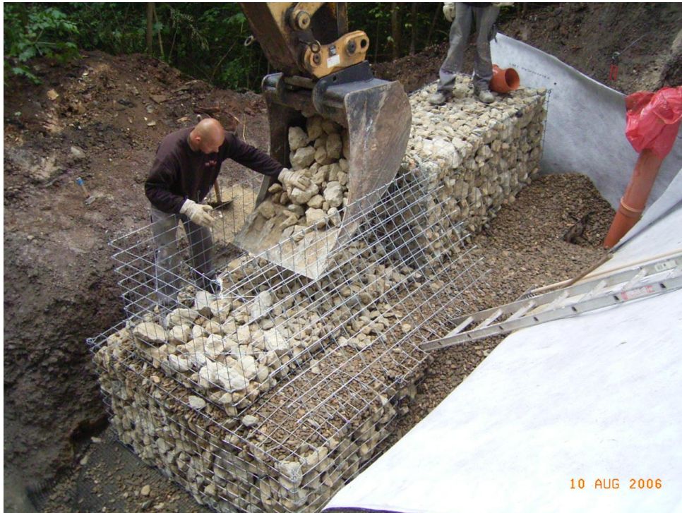
Errichtung der Gabionenwand 2008
