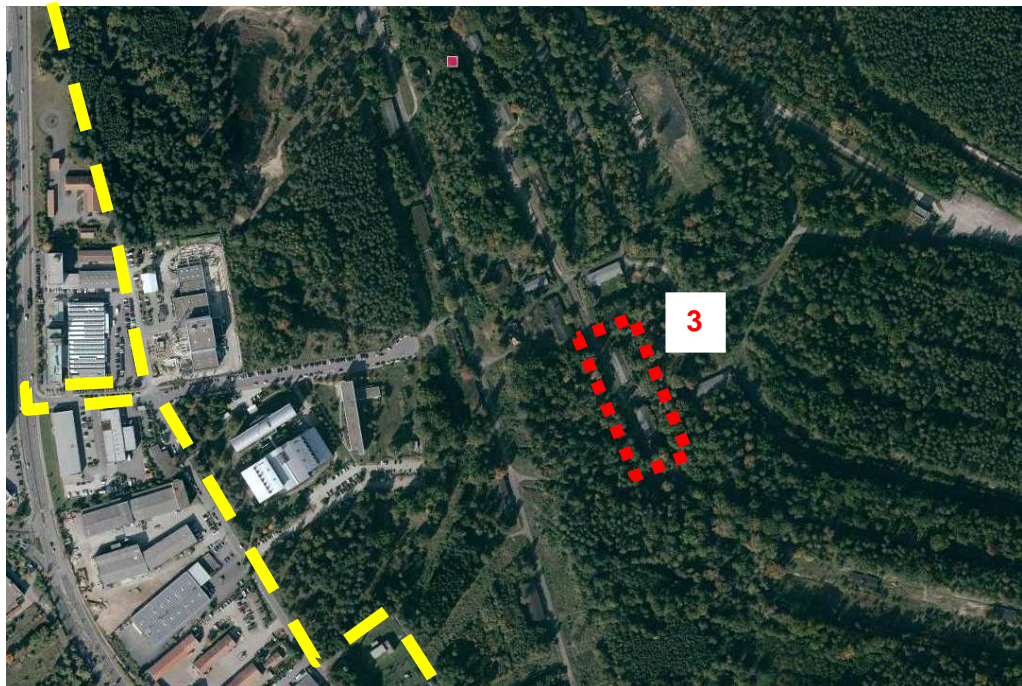
Abb. 24: Lage der früheren „Messerschmitt - Hallen“ (mit Ziffer Nr. 3 gekennzeichnet und mit rot gestrichelter Linie umrandet, Abgrenzung Geltungsbereich gelb gestrichelt schematisch dargestellt, Luftbild genordet, o. M., Quelle: Eigene Darstellung)
