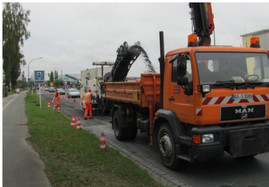
Deckensanierung mit eigenem Baultrupp
