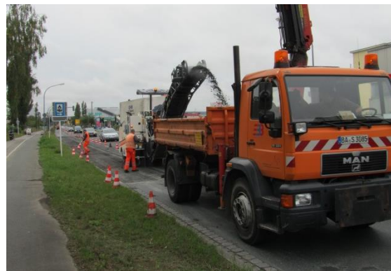
Deckensanierung mit eigenem Bautrupp
