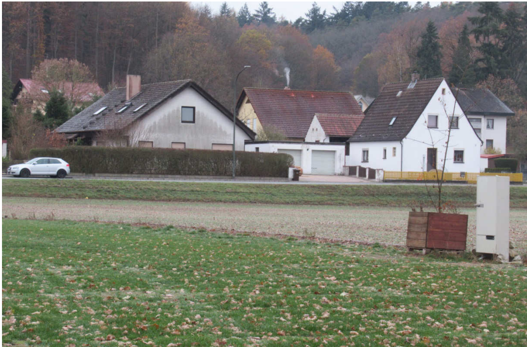
Wohnhäuser Karl-May-Straße 3 und 4
