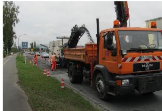
Im Rahmen des Straßenunterhaltes wurden durch die eigenen Bautrupps rund 8.000 m<sup>2</sup> Asphaltdecken erneuert. Im Einzelnen wurden rund 7.500 m<sup>2</sup> Asphalt in folgenden Straßen abgetragen und neu aufgebracht:
