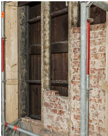
Öffnung der Vermauerung / Fund der gotischen Rippen
