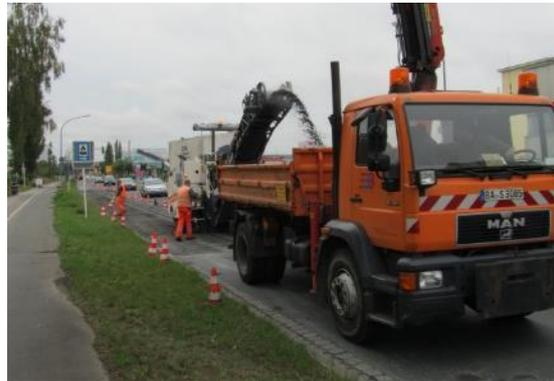
Im Rahmen des Straßenunterhaltes wurden durch die eigenen Bautrupps rund 2.000 m<sup>2</sup> Asphaltdecke erneuert. Im Einzelnen wurden rund 1.500 m<sup>2</sup> Asphalt in folgenden Straßen abgetragen und neu aufgebracht:
