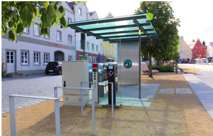
E-Bike-Ladestation und Servicepunkt in Aidenbach; https://www.passauerland.de/attraktion/e-bike-ladestation-mit-luftpumpe-am-marktplatz-aidenbach-39ade7477d
