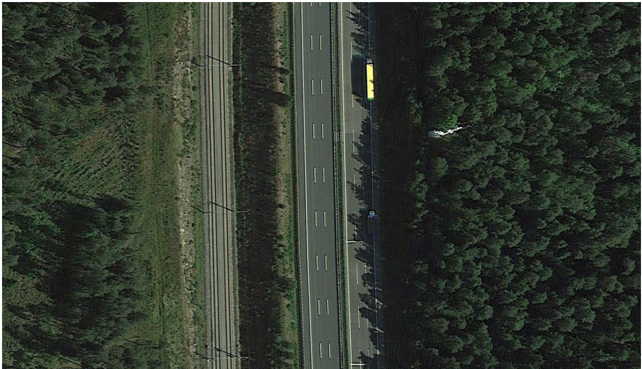
Abbildung: Bündelung der Neubaustrecke Nürnberg - Ingolstadt mit der A9, südlich Nürnberg
