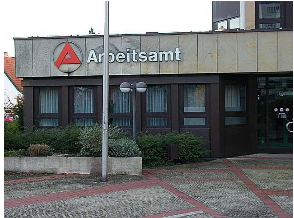
Ansicht aus nördlicher Richtung; rechts: Separat zu nutzender Eingangsbereich
