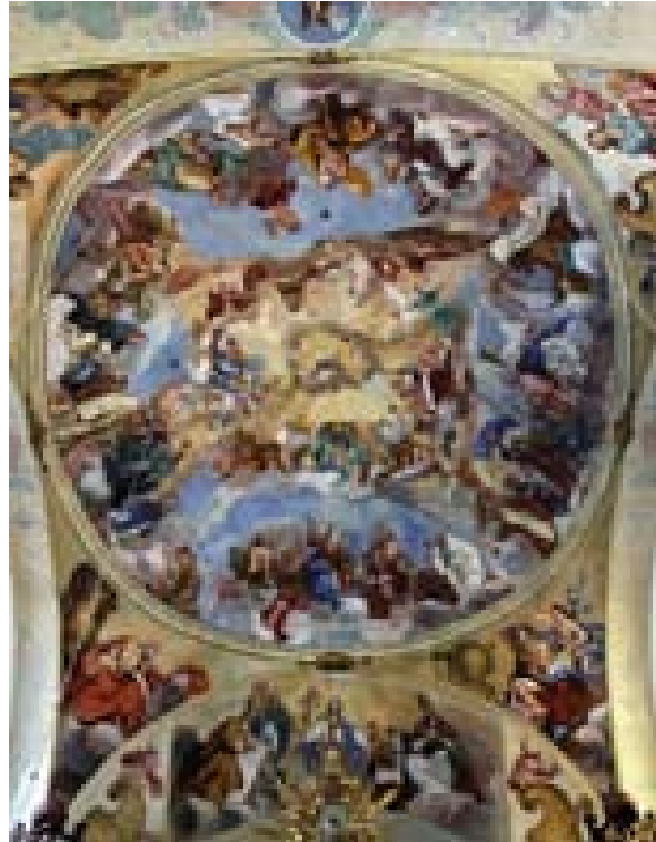
Abb. 11.23: Die Kuppel der St.-Getreu Kirche ist derzeit stark gefährdet.
