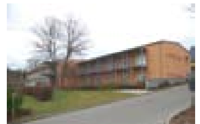
Abb. 4.17: Haus 8 (geriatriische Rehabilitation)
