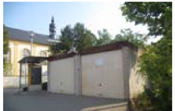
Abb. 4.10: Die Doppelgarage südlich der St.-Getreu-Kirche ist ein Beispiel für störenden Baubestand im Untersuchungsgebiet.
