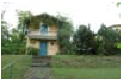
Abb. 4.36: Faulwetter'sches Gartenhaus südwestlich der Villa Remeis
