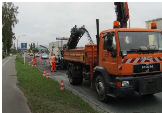
Deckensanierung mit eigenem Baurupp
