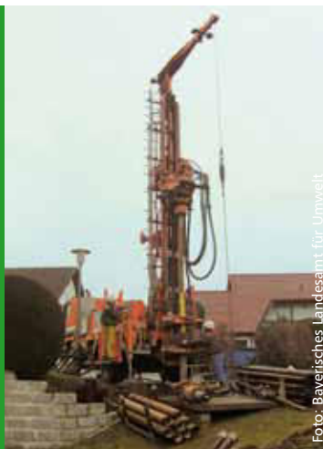
Bohrung für Erdwärmesonden
