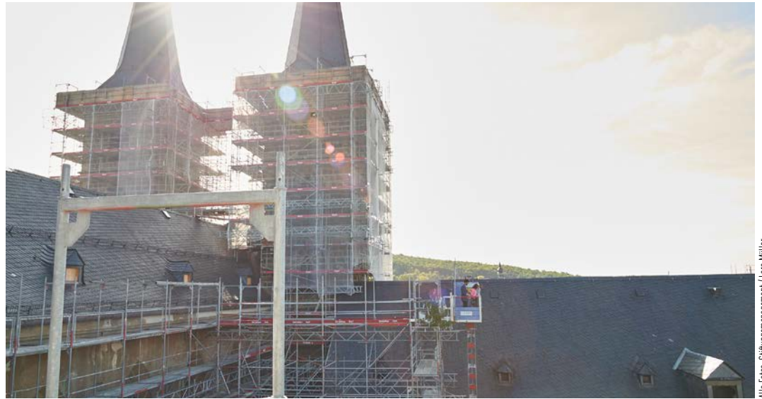
Festakt: Richtspruch in luftiger Höhe.
