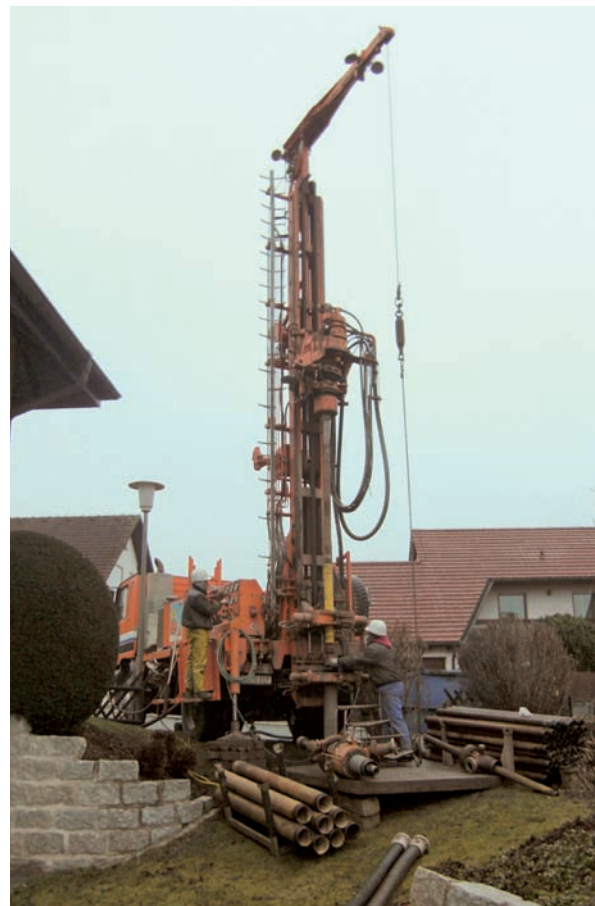
Abb. 1: Bohrung für Erdwärmesonden (Quelle: LfU)
