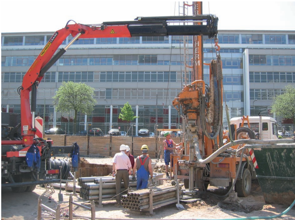
Abb. 2: Bohrung für Erdwärmesonden (Quelle: BWP)
