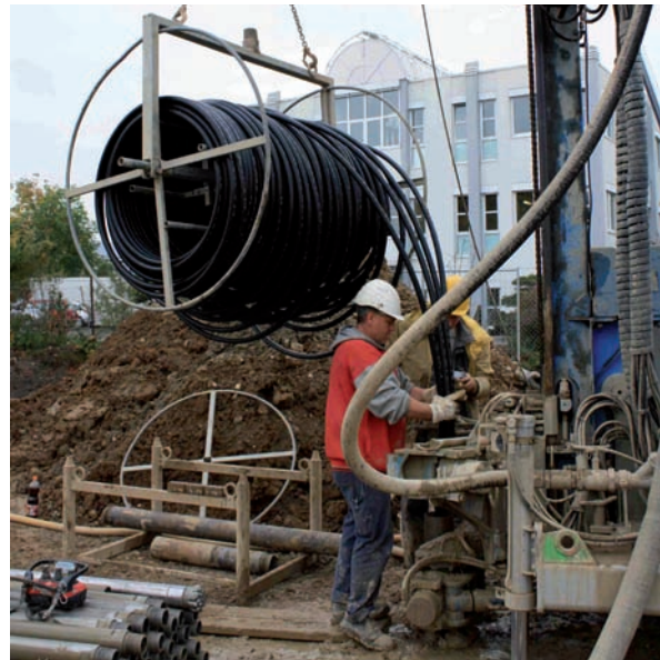
Abb. 7: Einbringen einer Erdwärmesonde (Quelle: LfU)
