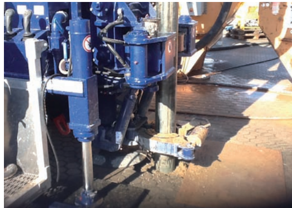
Abb. 6: Bohrung für eine Erdwärmesonde (Quelle: BWP)
