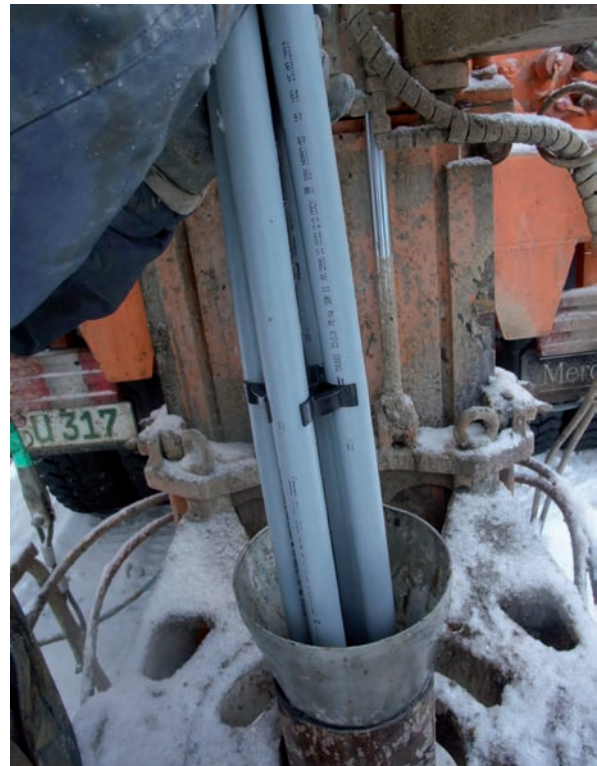
Abb. 8: Einbringen einer Erdwärmesonde mit Innenabstandshalter (Quelle: LfU)
