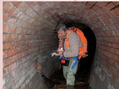
Die Abteilung „Entwässerung“ ist für die gesamte Abwasserentsorgung der Stadt zuständig. Das ca. 100 Jahre alte Kanalnetz dient der Ableitung des Abwassers über viele Pumpwerke in die Kläranlage.
