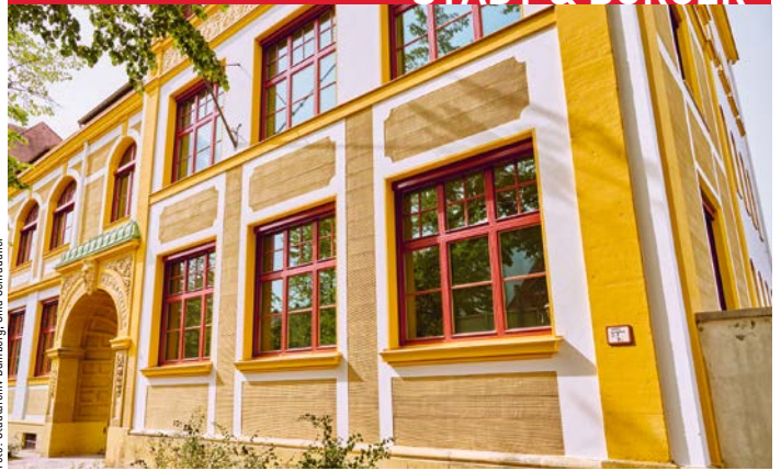
Erstrahlt wieder in vollem Glanz: die Fassade der Luitpoldschule.
