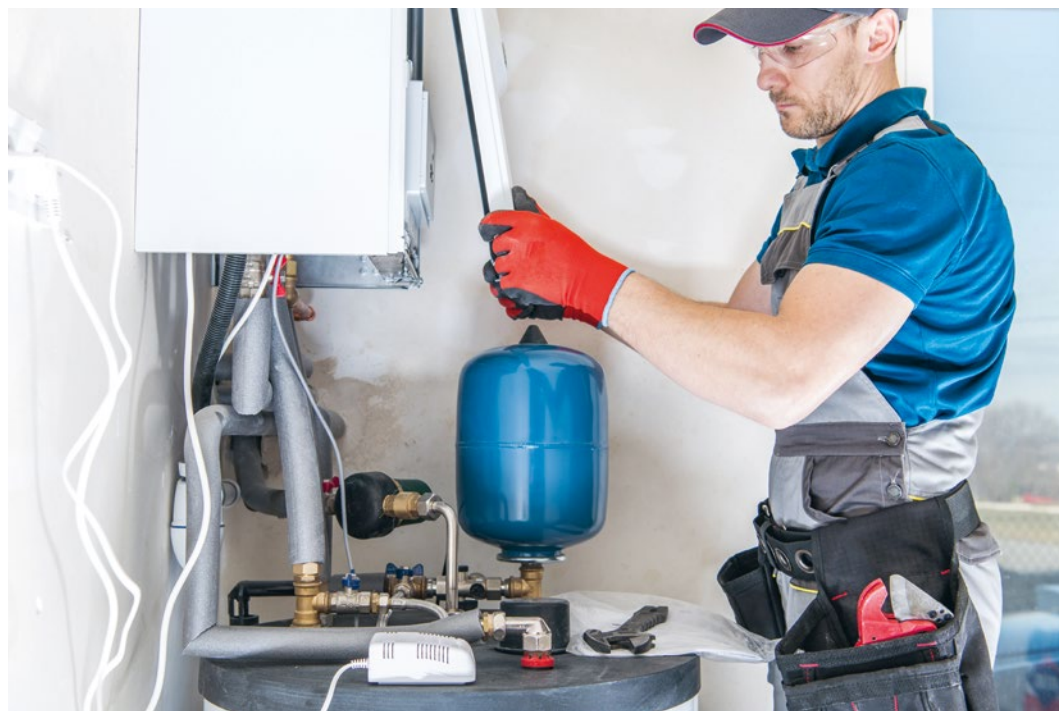
Viele Gebäude in Bamberg werden mit einer Gastherme beheizt.
