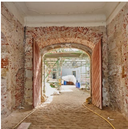
Durch diesen Torbogen kommt man auf die Baustelle.
