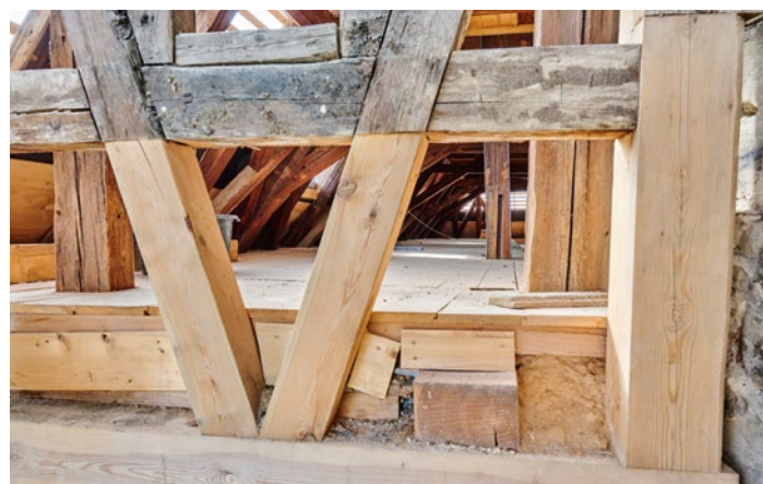
Die Dachbalken werden nur ersetzt, wenn die Substanz schon zu sehr angegriffen ist.
