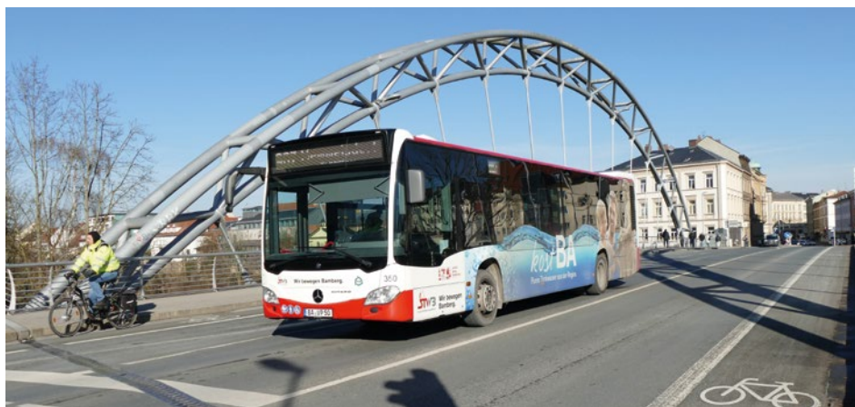
Fotos: Stadtwerke Bamberg
