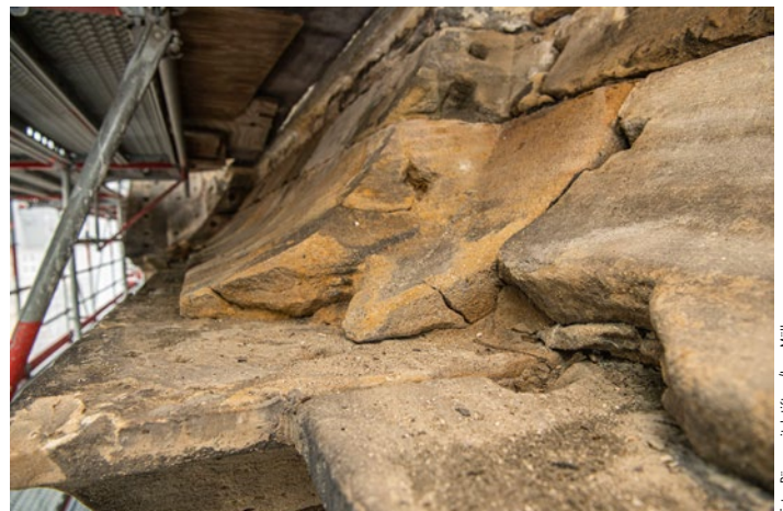
Verwittertes Sandsteingesims am Westwerk
