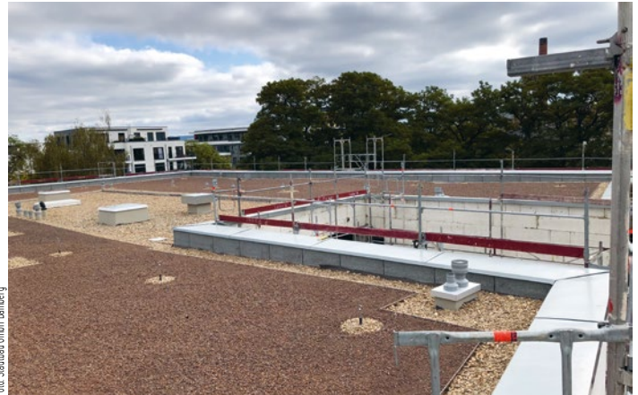
Foto: Stadtbau GmbH Bamberg
