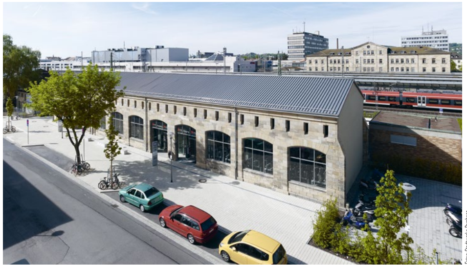
Fotos: Stadtwerke Bamberg
