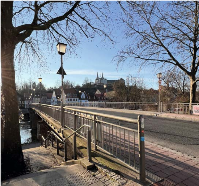
Die fast 80 Jahre alte Markusbrücke muss saniert werden. Die Vollsperrung für die Sanierungsarbeiten beginnt am 18. März 2024 und soll bis Ende Juli und damit rechtzeitig vor der Sandkirchweih abgeschlossen sein.
