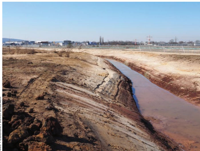
Der neue Bachlauf verläuft zwischen dem Flugplatzgelände und dem Brose-Areal.
