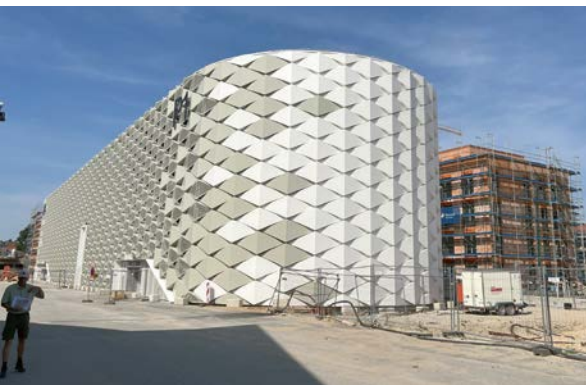
Bald fertiggestellt ist das architektonisch außergewöhnliche Parkhaus P1 der Stadtwerke Bamberg.
