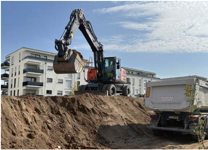
Ein Bagger schaufelt Teile des Erba-Erdhaufens in einen Lkw
