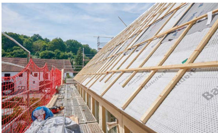
Der Dachstuhl erhält eine moderne Dämmung und neue Dach- und Gaubenfenster.
