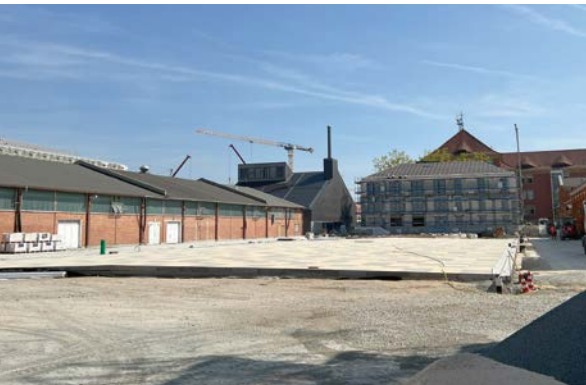
Blick auf die Baustelle für den zukünftigen Kulturhof. Im Hintergrund die in schwarz gehaltene Energiezentrale der Stadtwerke Bamberg.
