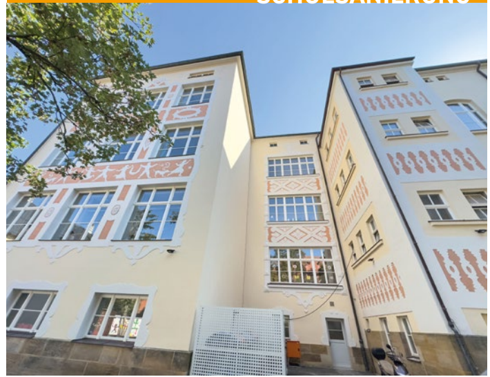
Die Fassade im Hinterhof der Domschule war bereits vor zwei Jahren saniert worden.
