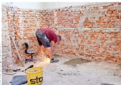
Das Hauptaugenmerk der Maßnahmen gilt der grundlegenden Erneuerung der Sanitäreinrichtungen.
