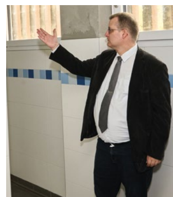
Aufwändige Sanierung der Schultoiletten: Finanzreferent Bertram Felix erläutert die Arbeiten in den WC-Räumen der Erlöser-Mittelschule.
