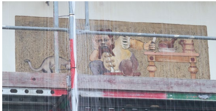
An der Fassade der Luitpoldschule werden auch die Märchenmalereien schon bald im neuen Antlitz erstrahlen.
